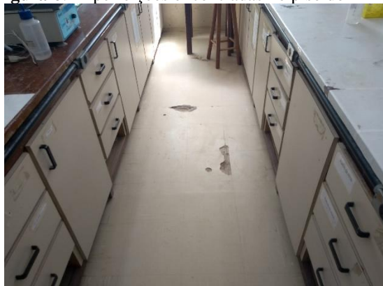
Figura 6: Imperfeições encontradas no piso do LBE
