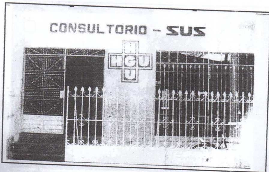
02 - Fachada do Consultório do S.U.S.
